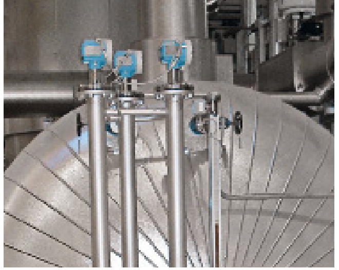
Buhar domunda Levelflex ile seviye ölçümü (Üçten ikisi mimarisi)
